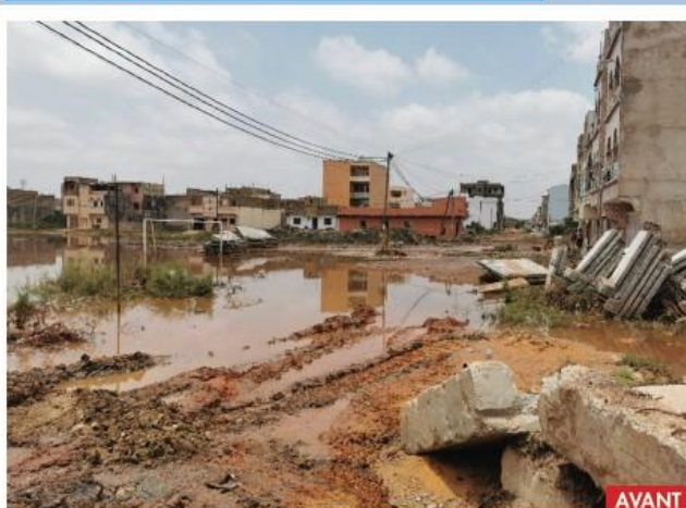
Unité 9 après les travaux bassin et PIC
