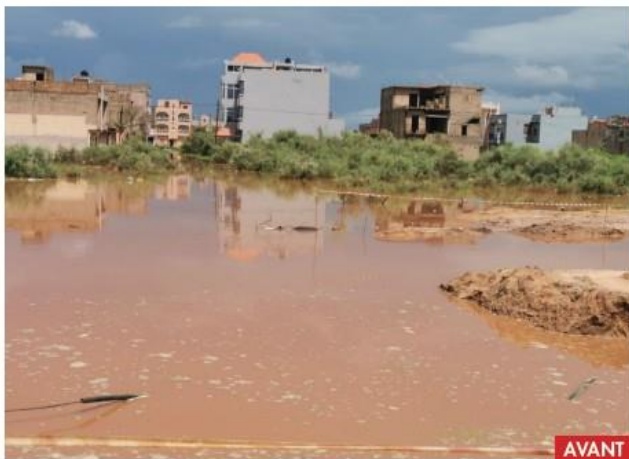
Bassin U3 avant et après les travaux
