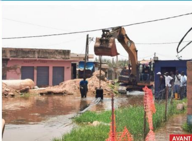
Branche 6 avant et après réalisation des travaux
