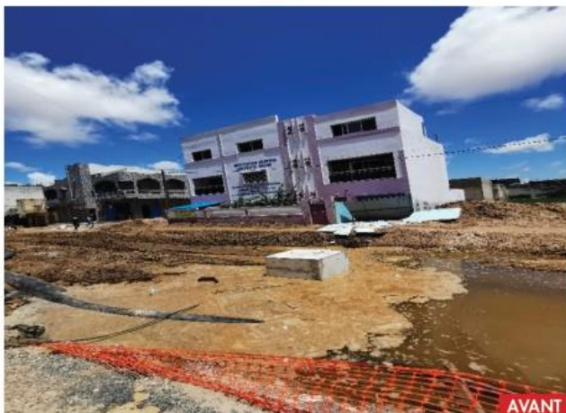
Branche 6 avant et après réalisation des travaux
